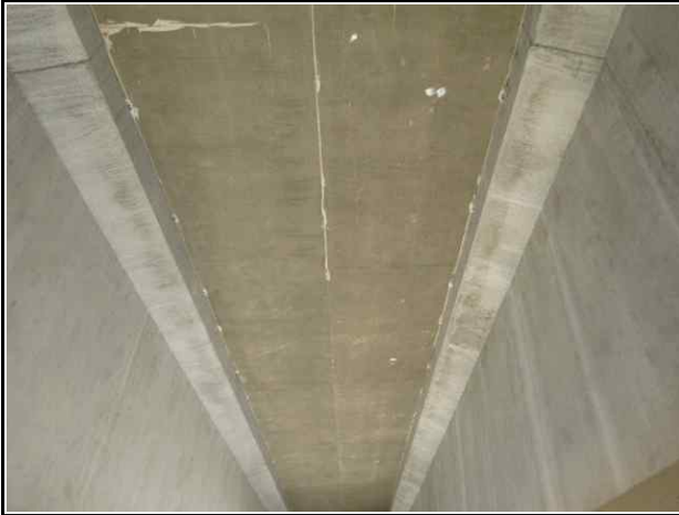
바닥판 하면 상태양호(옥산방향)
