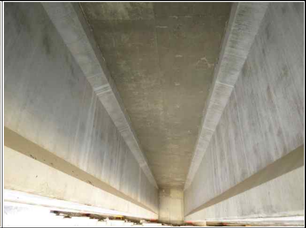
바닥판 하면 상태양호(옥산방향)
