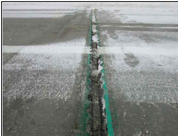
신축이음 상태양호(A1, 옥산방향)
