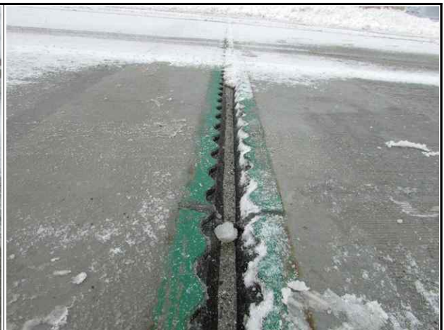
신축이음 상태양호(A2, 옥산방향)
